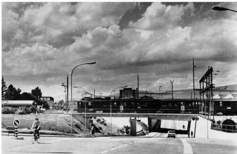
Die 1966 fertiggestellte Bahnunterführung der Bützbergstrasse
