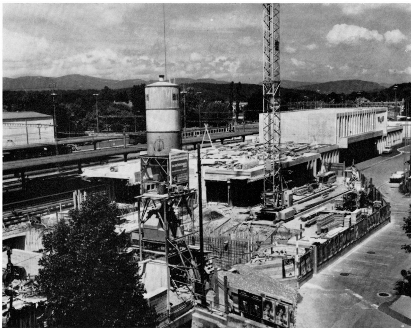
Der Bahnhofneubau – Stand der Arbeiten im Sommer 1970
