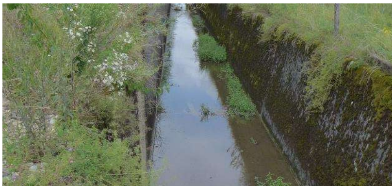
Abbildung 27: Der Kanal des Güllebachs, darunter liegt die ARA-Leitung (Foto 108).
