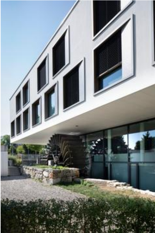
Das Wohn- und Geschäftshaus der Architekten Markus Lüscher. Das noch vorhandene alte Wasserrad konnte erhalten und in den Neubau integriert werden. (Bild: Gaeten Bally / Keystone)
