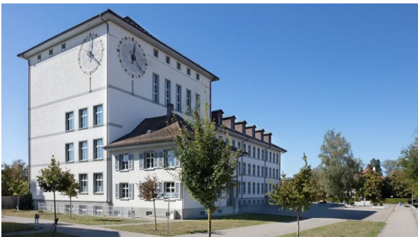
Bildungsenemble Kreuzfeld: Das Schulzentrum umfasst sechs Bildungsbauten aus über einem Jahrhundert. Das von Hans Klauser 1928–1930 realisierte und kürzlich renovierte Schulhaus nimmt hier eine prominente Rolle ein. James Batten/Schweizer Heimatschutz
