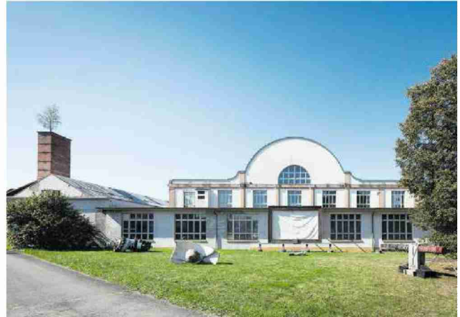
Das Areal der ehemaligen Porzellanfabrik wird zu einem lebendigen Stadtquartier.
