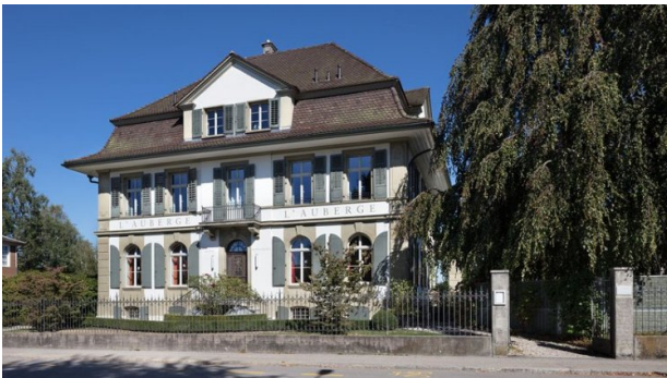
L'Auberge: Zwischen Dorfzentrum und neuem Bahnhof entstand ab den 1860er-Jahren ein Villenquartier mit grosszügigen Gärten. Dazu gehört auch diese Villa einer wohlhabenden Kaufmannsfamilie, die heute als Hotel und Restaurant genutzt wird. James Batten/Schweizer Heimatschutz
