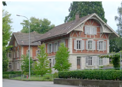
Abbildung 4-18: Baustruktur mit Qualität
