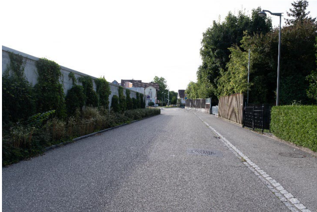
Abbildung 47: Bestand Blickrichtung Bützbergstrasse (eigene Aufnahme)
