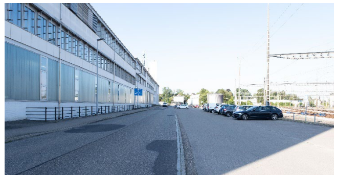
Abbildung 17: Eisenbahnstrasse Bestand (eigene Aufnahme)
