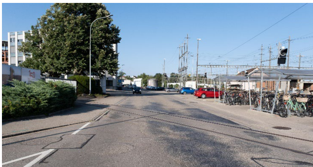
Abbildung 16: Eisenbahnstrasse Bestand (eigene Aufnahme)
