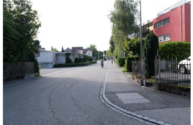
Abbildung 48: Bestand Blickrichtung Bützbergstrasse (eigene Aufnahme)
