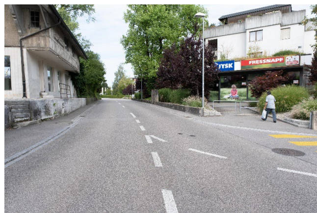
Abbildung 22: Mangelhafte Fussverkehrsinfrastruktur westlich des Knotens Bahnhofstrasse
