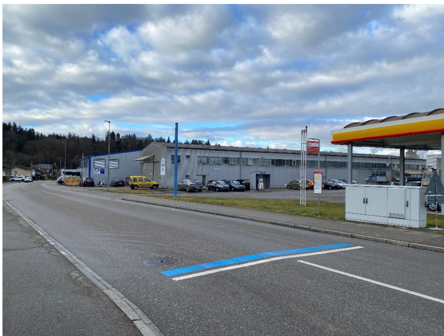
Abbildung 33: BHS Dennli, Richtung Bahnhof Süd / Thunstetten
