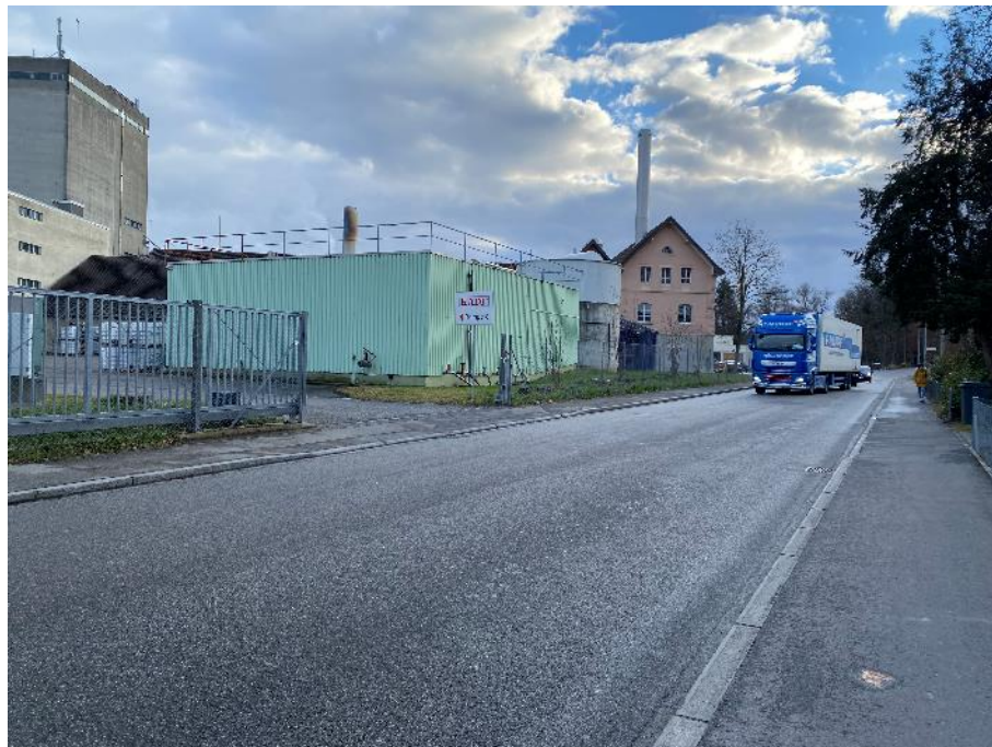
Abbildung 19: BHS Bahnhof Süd, Blickrichtung Süden
