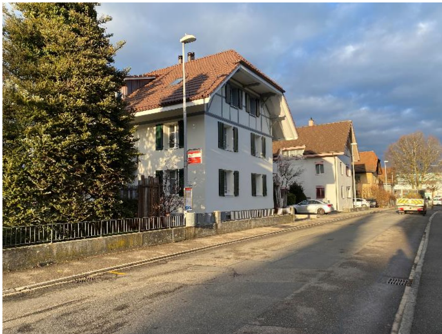
Abbildung 6: BHS Gaswerk Richtung Osten
