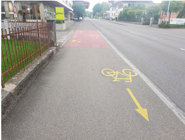
Abbildung 3: Foto Bodenmarkierung auf Rad-/Fussweg
