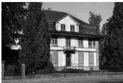
29 Aarwangenstrasse, Villa, um 1870
