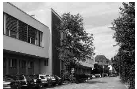
53 Ringstrasse, Fabrikgebäude ab 1961
